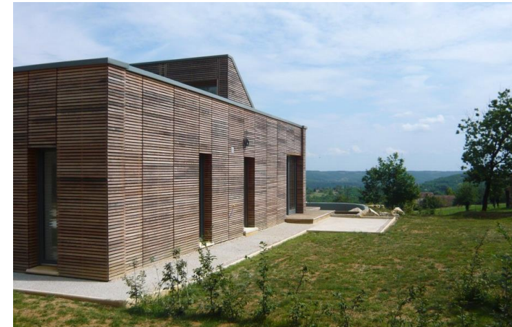
Figure 22 : Maisons individuelle bioclimatique, source : CAUE 31.
