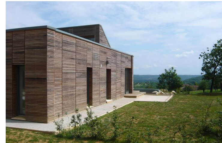
Figure 40 : Maisons individuelle bioclimatique, source : CAUE 31.
