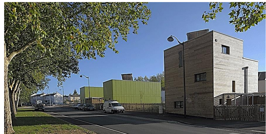
Figure 11 : Quartier des Merlattes (Bourges), source : Atelier Philippe Madec.
