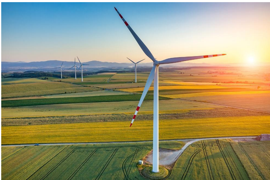
Figure 57 : Photographie d'un parc éolien (Source : ECO Delta)
