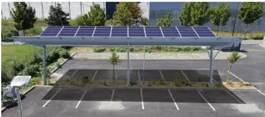
Figure 55 : Photographie d'installation de panneaux solaires sur parking (Source : APEX Energies)
